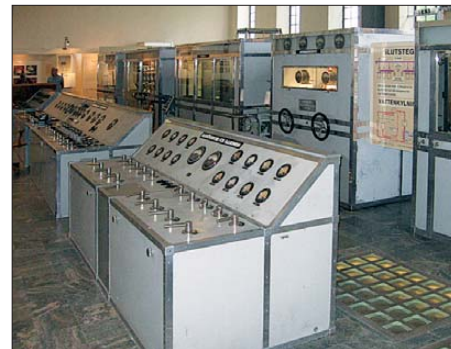
Der 150-kW-LW-Sender war von 1935 bis 1962 in Betrieb und ist fast unverändert erhalten.
