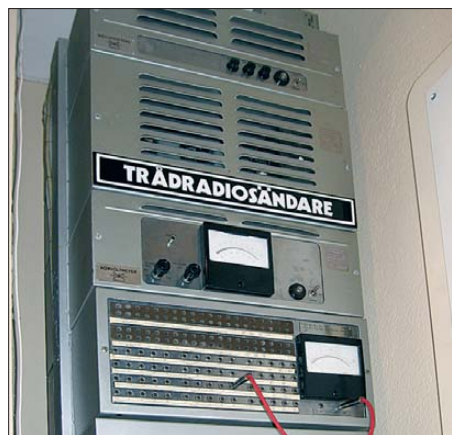
Drahtfunksender für LW-Kanäle zur Einspeisung ins Telefonnetz
