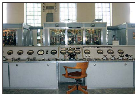
Bedienpult des 150-kW-Senders; im Hintergrund die Senderendstufe
