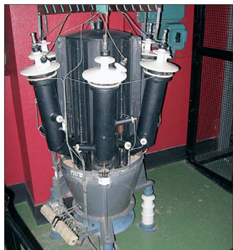
Quecksilberdampfgleichrichter aus dem Nebenraum zur Energieversorgung des Senders
